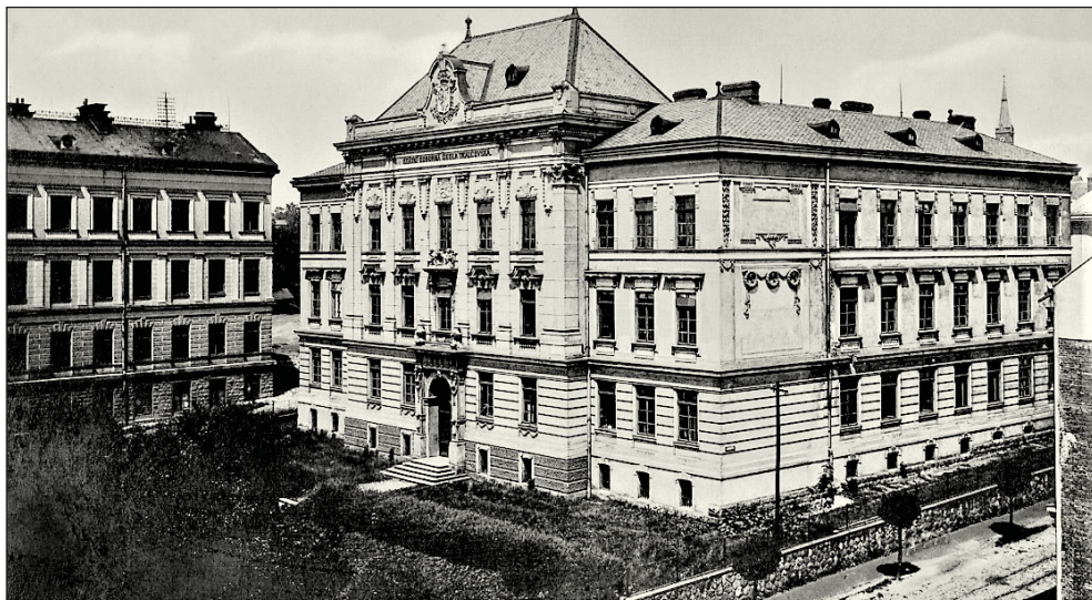
Soukromá odborná škola ve Frýdku, objekt někdejšího německého gymnázia Korunního prince Rudolfa, na tehdejší Wilsonově třídě, sídlo knihovny v letech 1922–1932, archiv autorek
